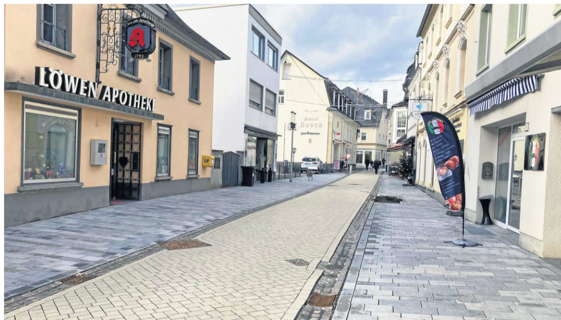
Erstrahlt in neuem Glanz: Die Wasserstraße in Attendorf ist fertig – und damit mehr oder weniger auch der große Umbau der Kernstadt.
